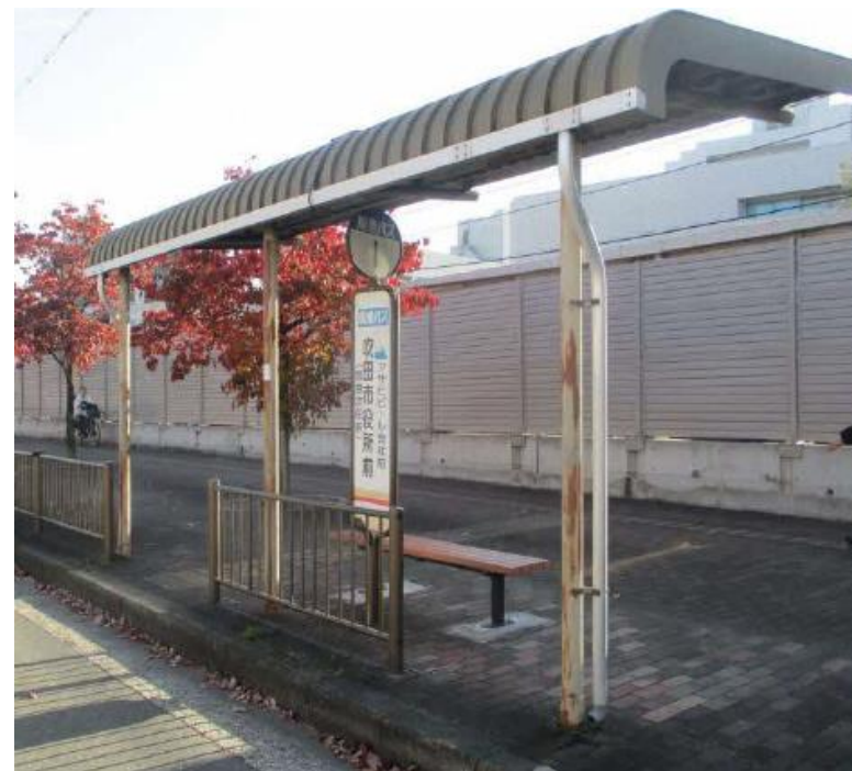
ベンチ補助事業完成写真
