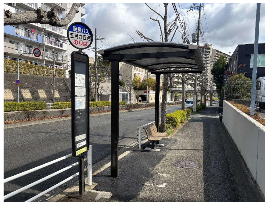
バス停上屋ベンチ設置事業完成写真
