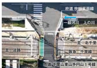
拡幅前の6mから最大18mに拡幅
