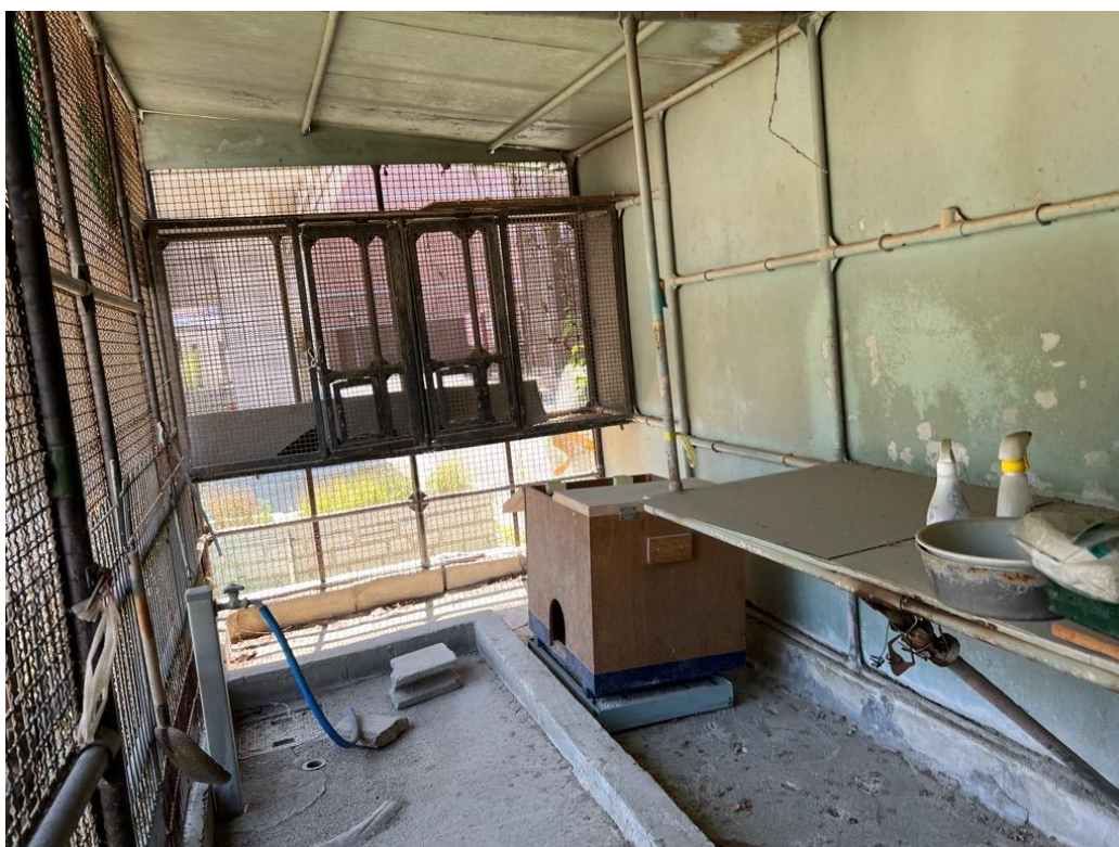
要撤去 1-2_飼育小屋（水道撤去）
