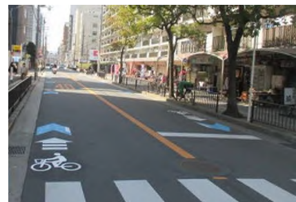
自転車レーン整備事例（垂水豊津線）
