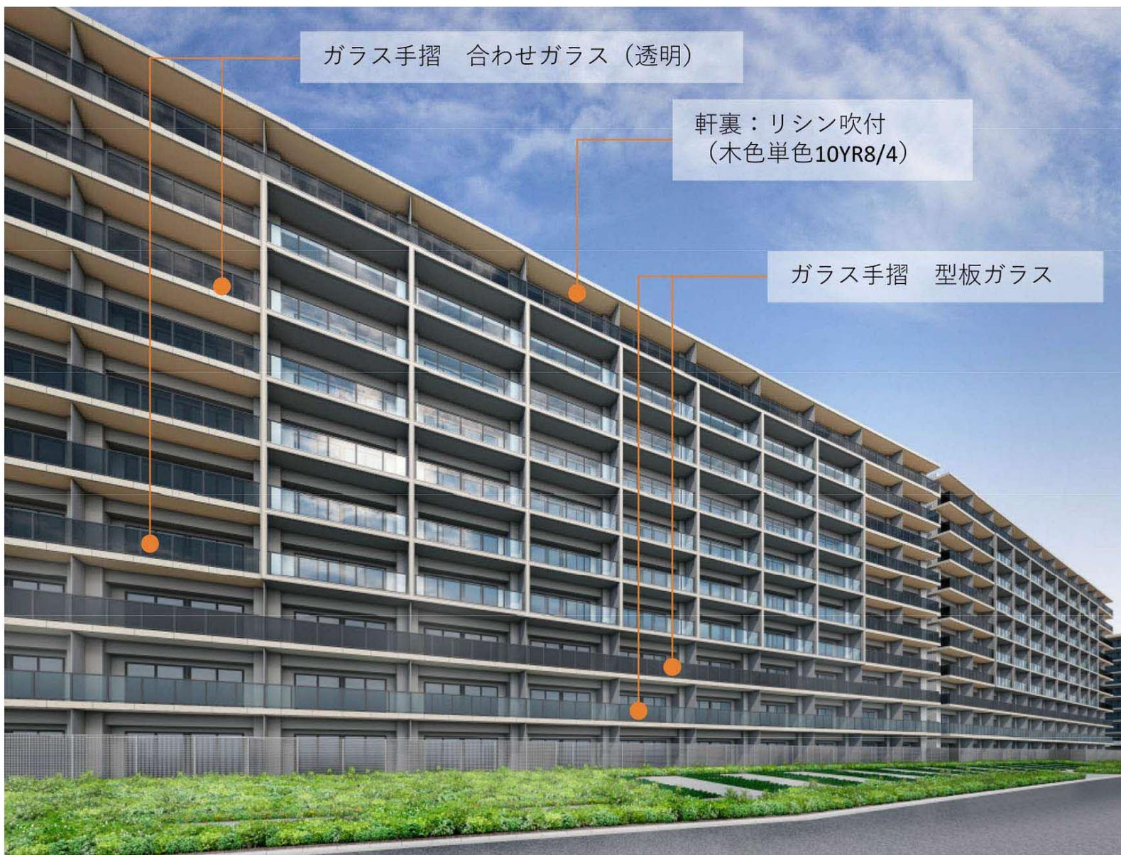
③ フレーム型に分節+軒裏の切り替えによる水辺分節 (再検討)
