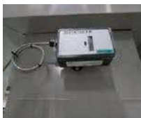
CO 2 センサを導入し、外気導入量を最適化！
