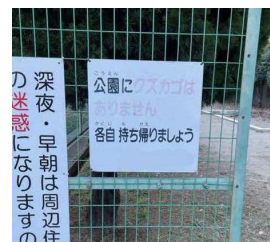
(例)表示面上部の赤文字が消えている
