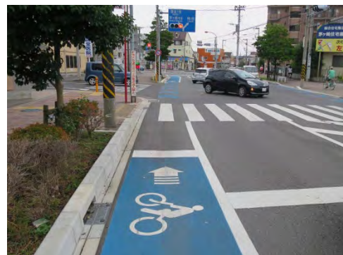
写真 5-9 停止線前出しの例(茅ヶ崎市)
