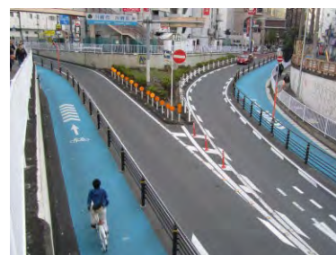
写真 5-1 整備例（川崎市）
