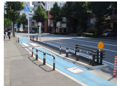
写真 5-18 交通島を設置している例（福岡市）
