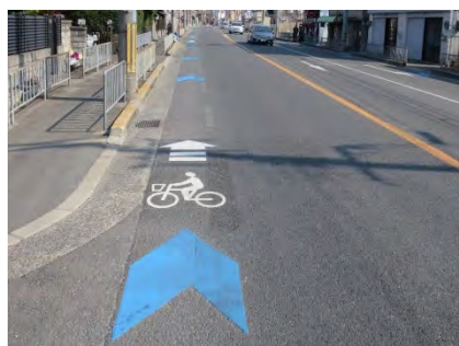
写真 5-19 路面表示設置例（吹田市）
