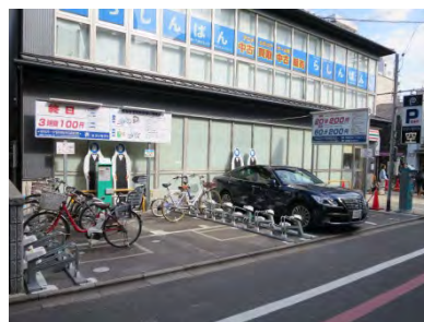
写真 5-26 駐車場の一部を活用した民間自転車駐車場の例（京都市）
