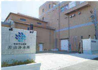
耐震基準を満たした建物 (片山浄水所)
