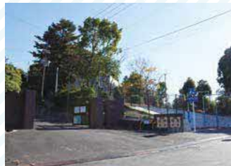
場内の配水池と水道管を耐震化 (津雲配水場)
