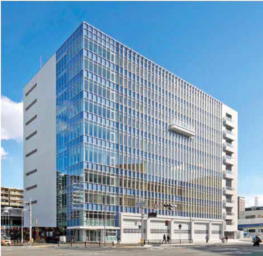
南千里駅前に整備が進められてきた総合防災センター
