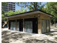
トイレの改修
