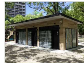
トイレの改修
