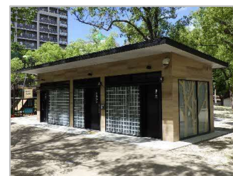
トイレの改修
