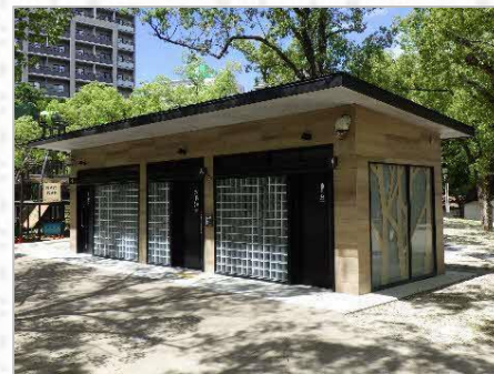
トイレの改修
