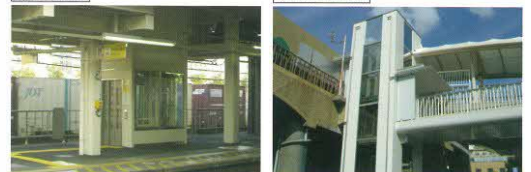
○ 駅構内及び郊外のエレベーター設置
