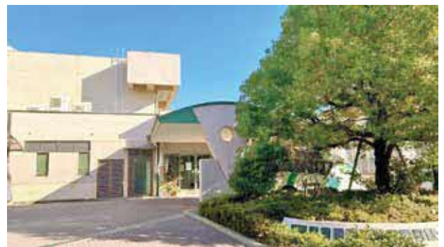
廃止予定の千里山西デイサービスセンター
