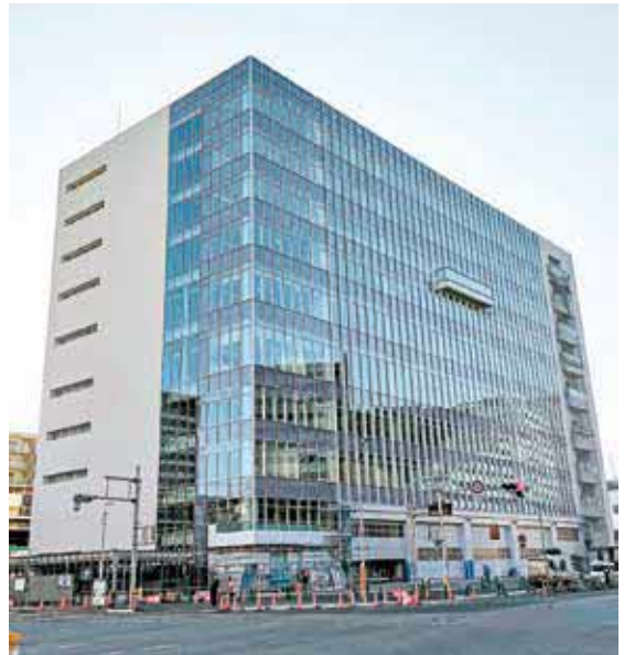
建設中の北部消防庁舎等複合施設
