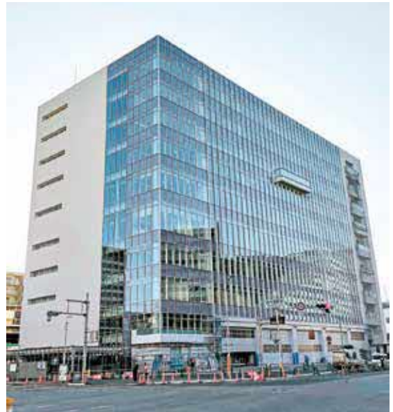
建設中の北部消防庁舎等複合施設
