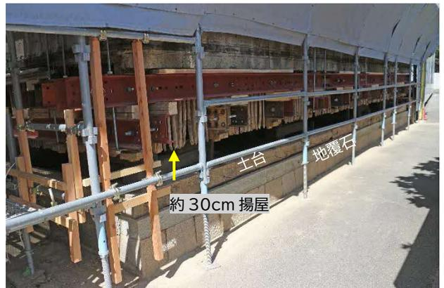
33 揚屋作業中 最終的には約30cm持ち上げて、土台、地覆石、柱脚部を修理できるようにしました。
