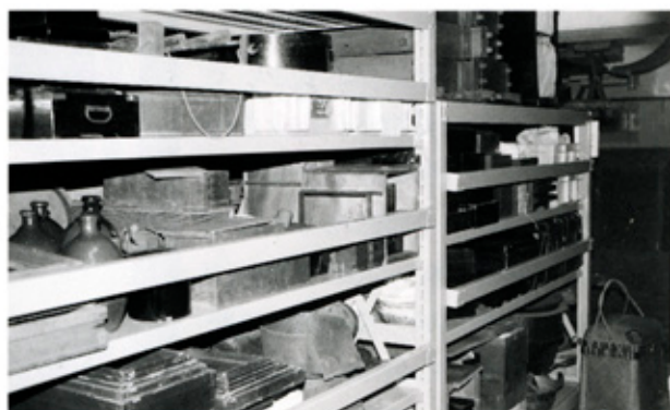
地震後取り付けられた転落防止金具(当館一般収蔵庫)
