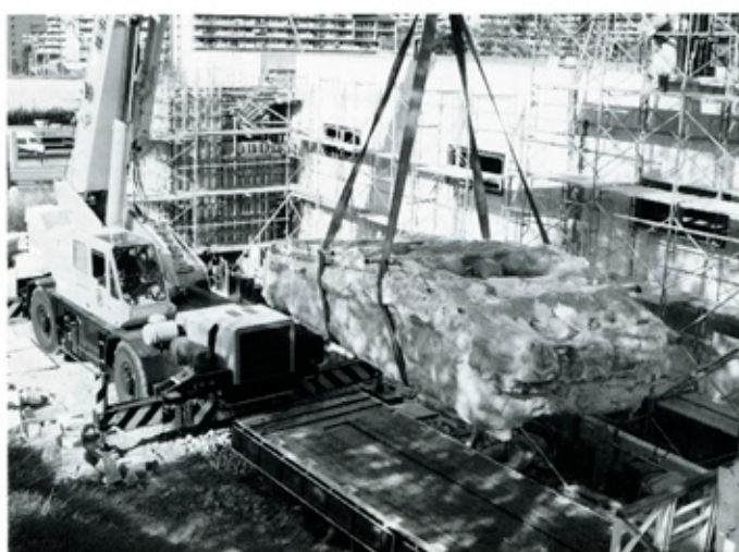
館へ搬入される移築須恵器窯跡
