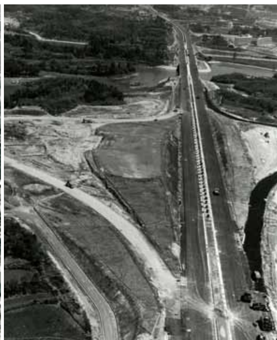
▲建設中の吹田サービスエリア (西日本高速道路(株)提供)
