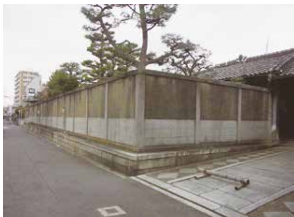
▲旧西尾家住宅 鉄筋コンクリート塀(外塀)
