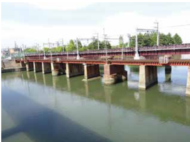
阪急電車千里線神崎川橋脚
