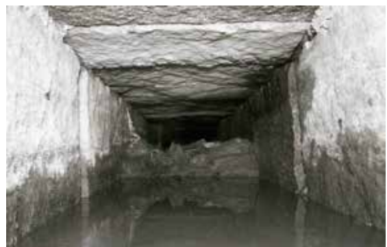
8 佐井寺くりぬき水路 ( 内部 )
