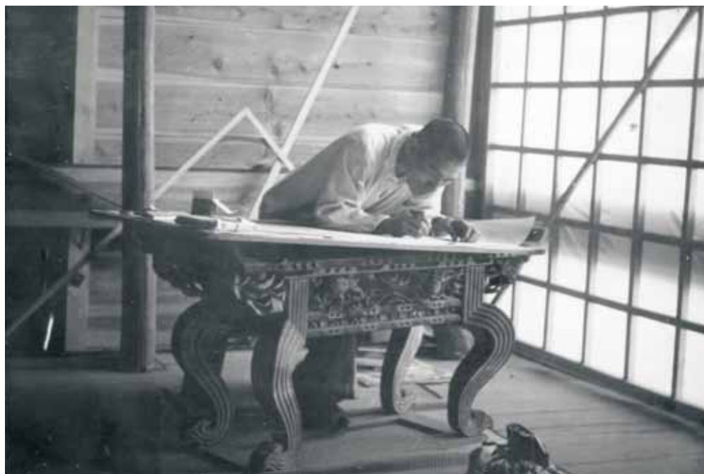
平等院での修復作業
