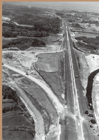
建設中の名神高速道路吹田SA (西日本高速道路(株)提供)
