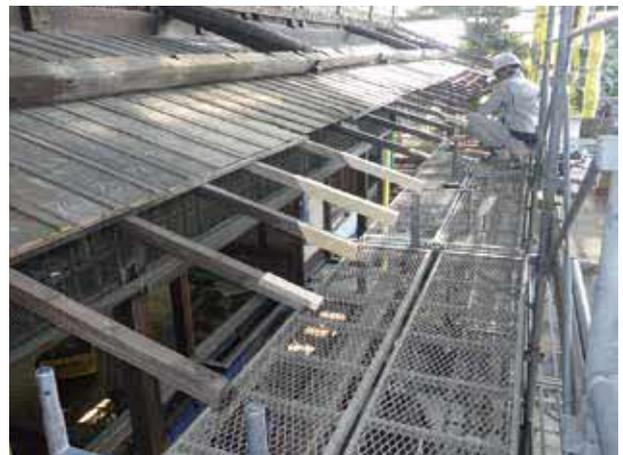
▲棟梁が下屋の垂木の補修作業を行っている様子
