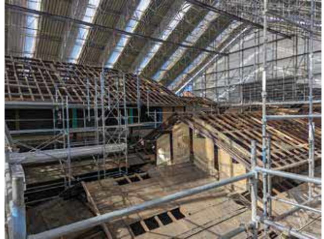
▲主屋屋根解体後
