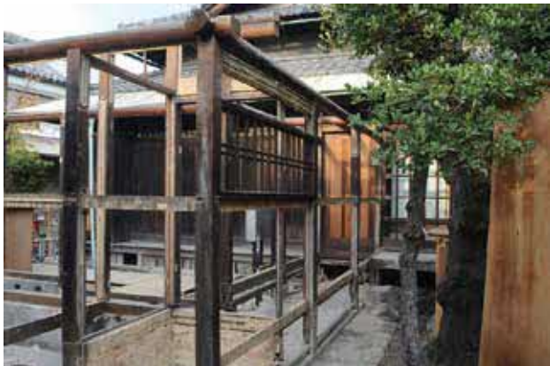
▲解体が進む旧西尾家住宅
