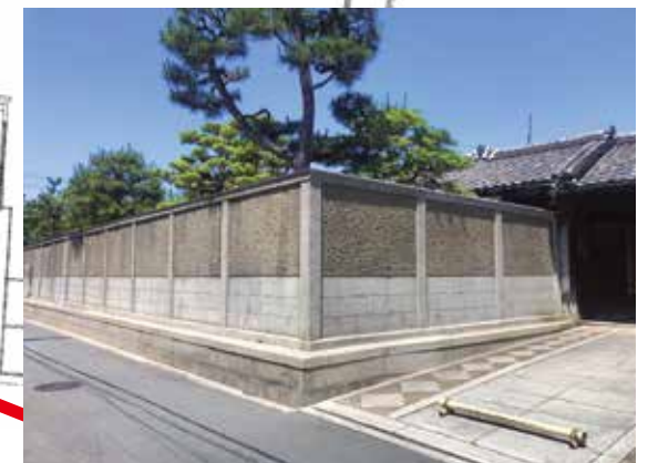
鉄筋コンクリート塀（修理後）
