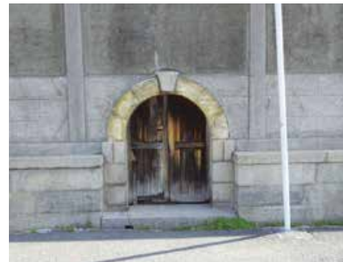
アーチ門（修理前）
