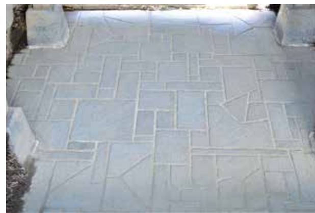
アーチ門石貼り
