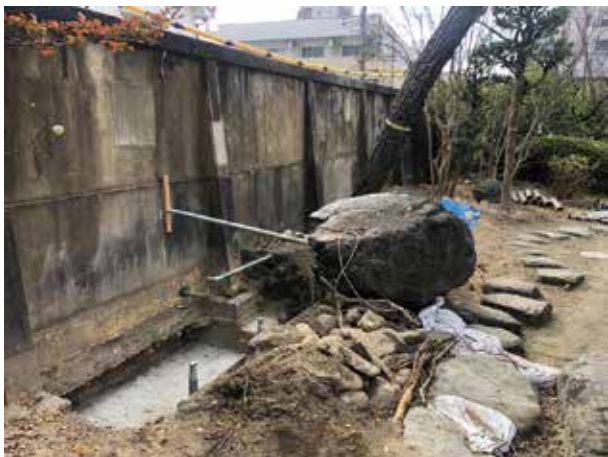
旧西尾家住宅外塀（鉄筋コンクリート塀）修理現場
