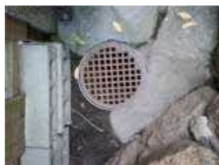
写真 3-2-4-28 雨水升（マンホール）
