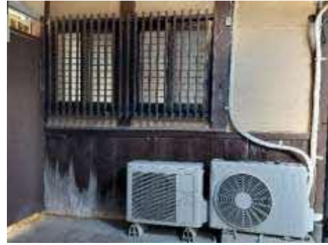
写真 2-1-1-4 腰板の腐朽
