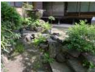
写真 3-2-4-16 給排水塩ビ管 (枯池)
