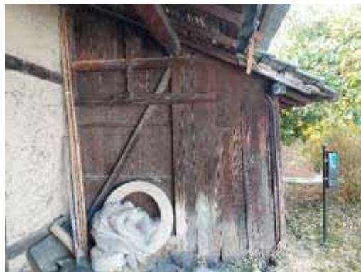
写真 2-1-1-24 納屋の増築部分
