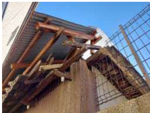
写真 2-1-1-23 納屋の屋根の現状
