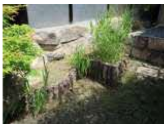
写真 3-2-5-71 改修痕・木杭土留
