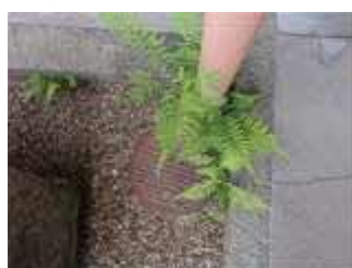
写真 3-2-3-28 雨水弁（マンホール）
