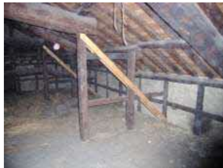
写真 2-1-1-2 母屋小屋裏の筋違い
