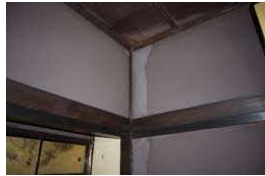
写真 2-1-1-6 壁の雨染み
