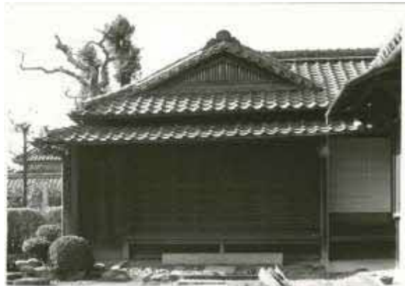
2-4-4-2 昭和50年代の玄関棟（式台玄関）
