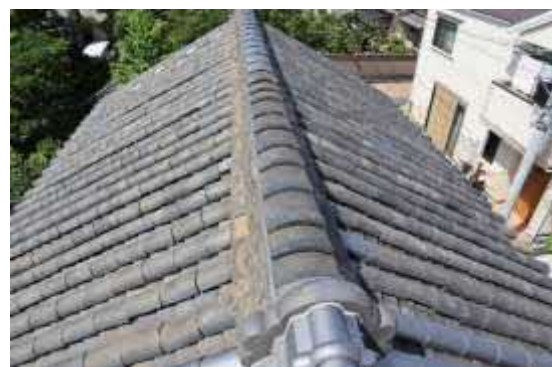
写真 2-1-1-18 土蔵一の本瓦葺部分
