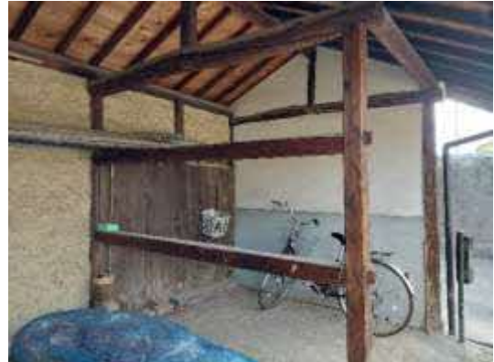
写真 2-1-1-20 キザラ小屋の柱（取替材）
