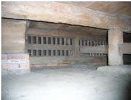
写真 2-1-1-5 土台下のレンガの敷き込み
