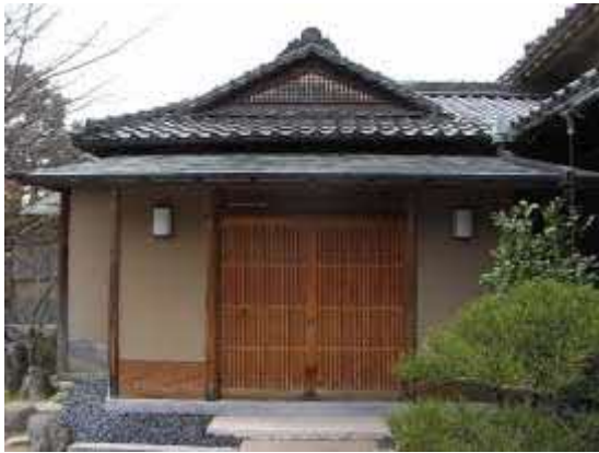
2-4-4-1 玄関棟（式台玄関）
