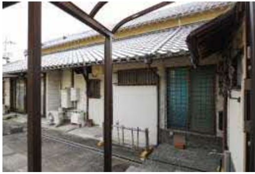
写真 2-1-1-3 増築された母屋北面
