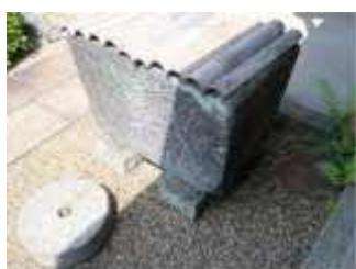
写真 3-2-3-22 防火弁（防火水槽）
