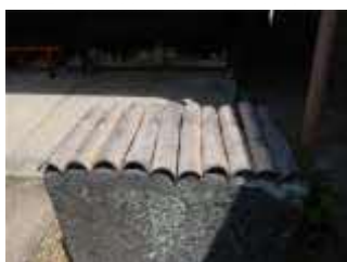
写真 3-2-3-18 防火升竹升蓋
