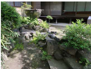
写真 3-2-4-16 給排水塩ビ管 (枯池)
