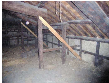
写真 2-1-1-2 母屋小屋裏の筋違い
