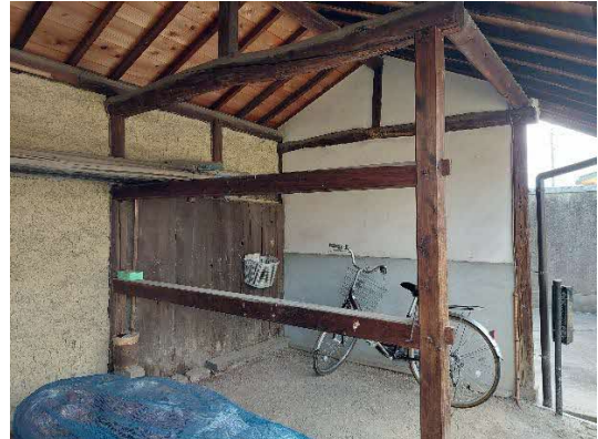
写真 2-1-1-20 キザラ小屋の柱（取替材）
