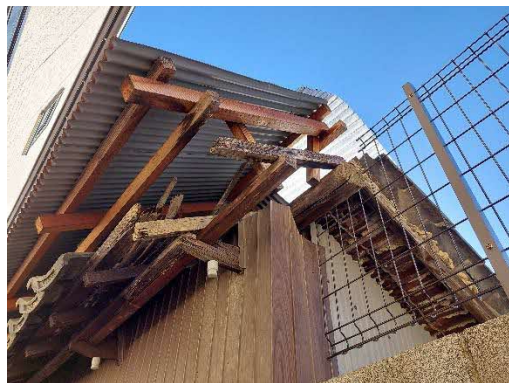
写真 2-1-1-23 納屋の屋根の現状
