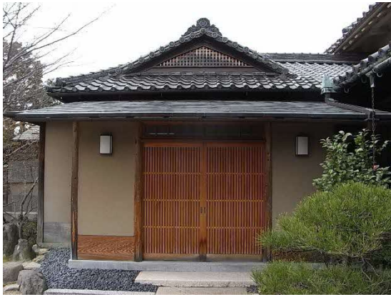
2-4-4-1 玄関棟 (式台玄関)
