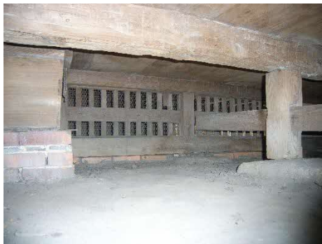
写真 2-1-1-5 土台下のレンガの敷き込み
