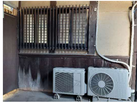
写真 2-1-1-4 腰板の腐朽
