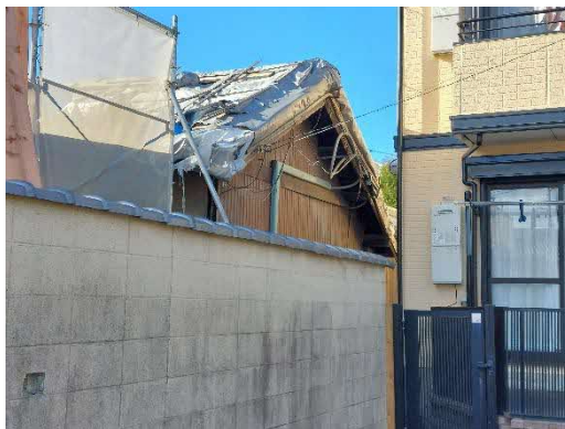
写真 2-1-1-21 井戸屋の屋根の現状
