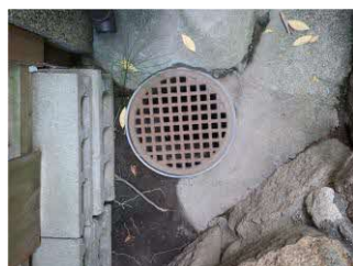
写真 3-2-4-28 雨水升（マンホール）
