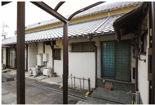
写真 2-1-1-3 増築された母屋北面
