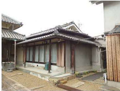
勘定部屋・外観
