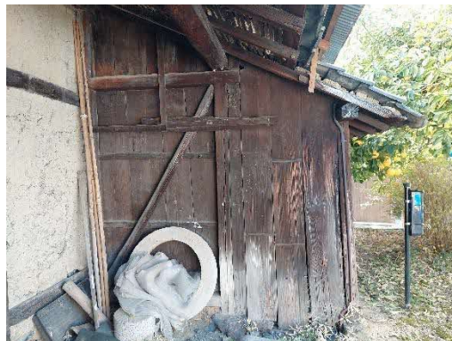
写真 2-1-1-24 納屋の増築部分
