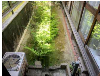
写真 3-2-4-17 水路遠景(中庭)
