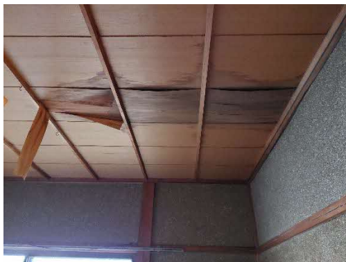
写真 2-1-1-13 勘定部屋増築部の天井
