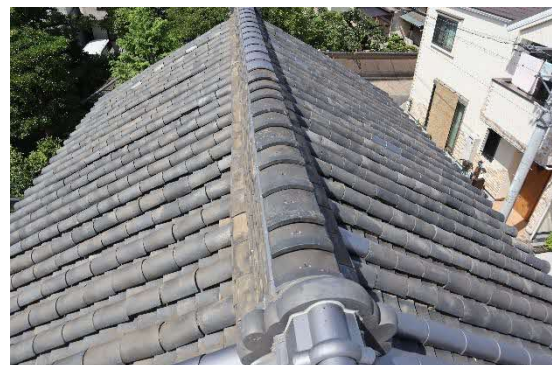
写真 2-1-1-18 土蔵一の本瓦葺部分
