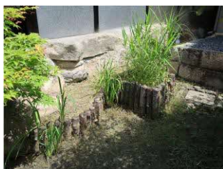
写真 3-2-5-71 改修痕・木杭土留
