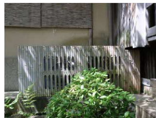
写真 3-2-1-20 空調設備隠し
