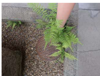
写真 3-2-3-28 雨水升 (マンホール)
