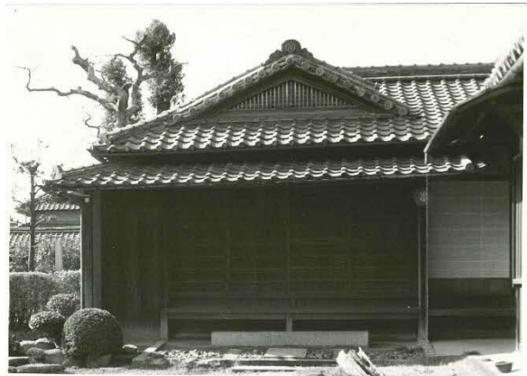
2-4-4-2 昭和50年代の玄関棟 (式台玄関)
