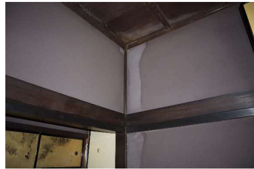
写真 2-1-1-6 壁の雨染み
