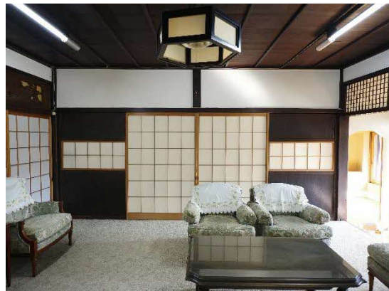
写真 1-3-3-1、1-3-3-2 土間側から見た洞差（左）と口の間側から見た洞差（右）
