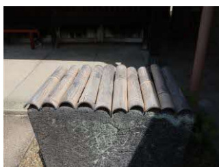
写真 3-2-3-18 防火升竹升蓋
