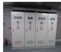
ポンプの回転をきめ細かくコントロールして、エネルギー効率を高めるインバータ盤！
