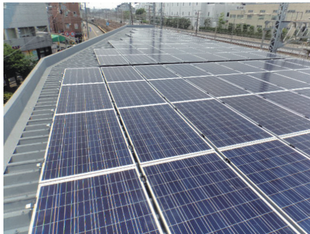
(写真：JR吹田駅前西自転車駐車場の屋根の様子)
