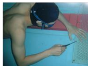
排水口等の重点点検
