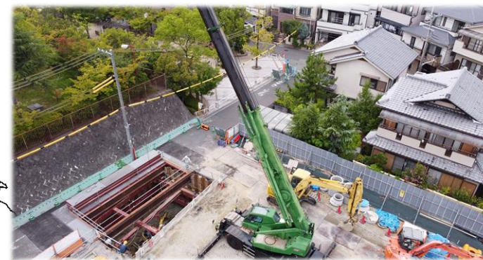
南千里分岐・片山浄水所送水管 布設中 (R3~R10)
