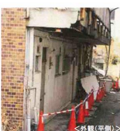
外壁、手すりが崩落した事例
