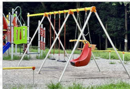
遊具の補修・更新
