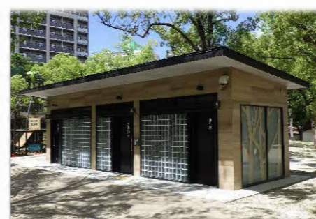
トイレの改修
