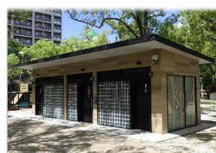
トイレの改修
