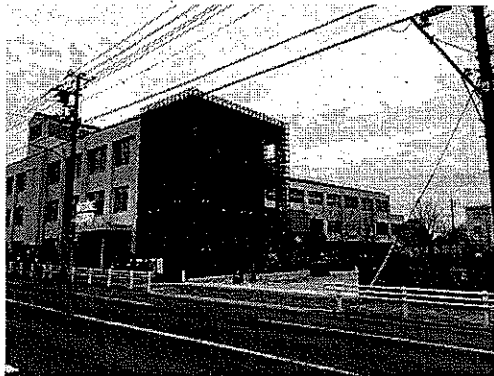
道路からの全景
