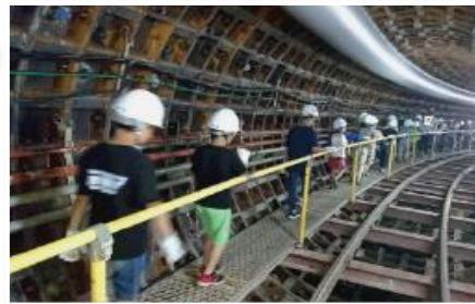
○掘削現場の見学
