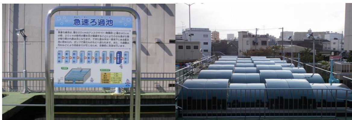
図 8-5-2 泉浄水所急速ろ過池写真
