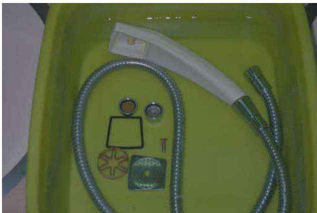
図2-2 シャワーヘッドの分解・清掃の例
