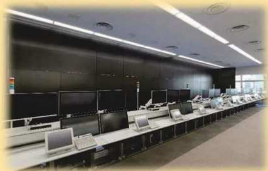
北大阪消防指令センター
