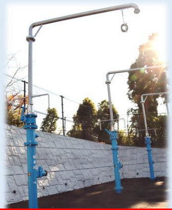
給水タンク車に補水するための水栓
