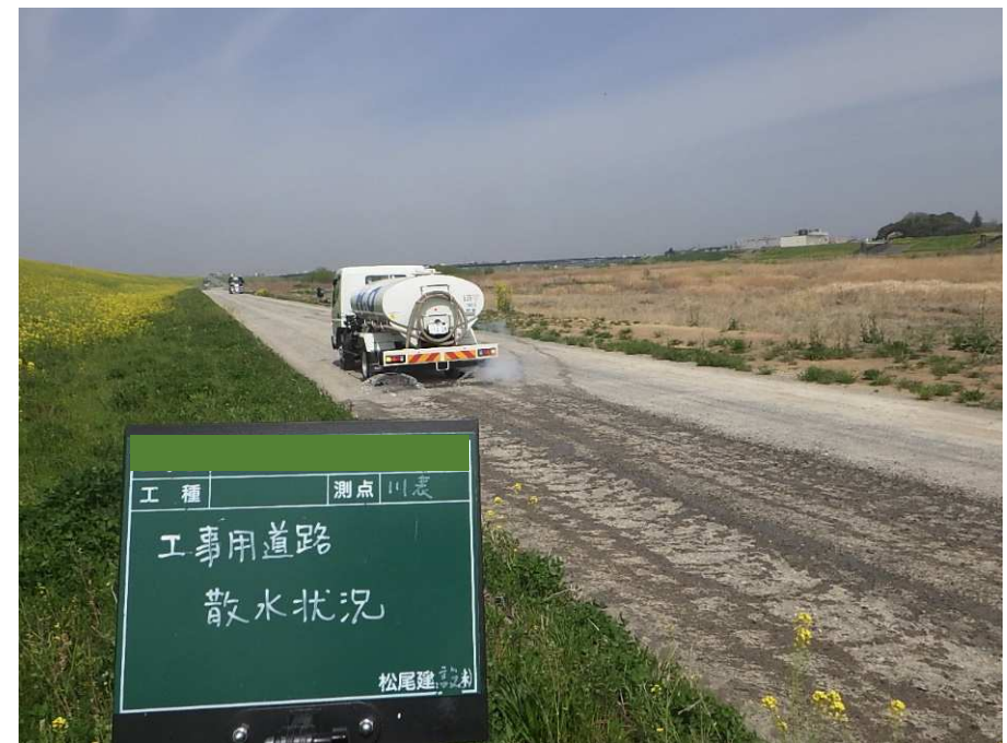
散水状況の例
