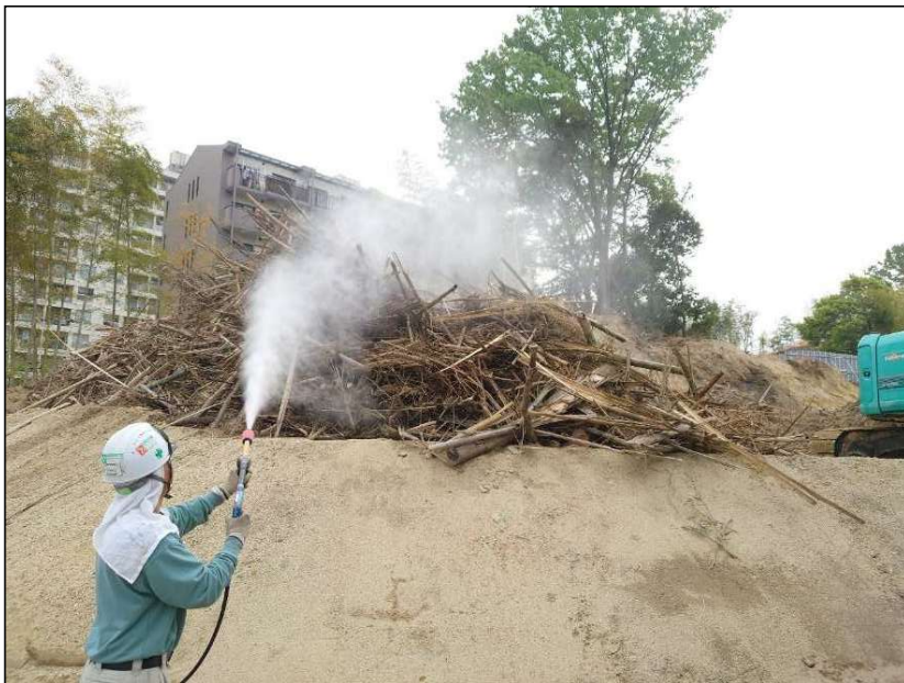
伐採材積込時の粉じん防止対策
