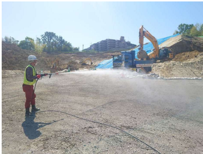
現場内の粉じん防止対策
