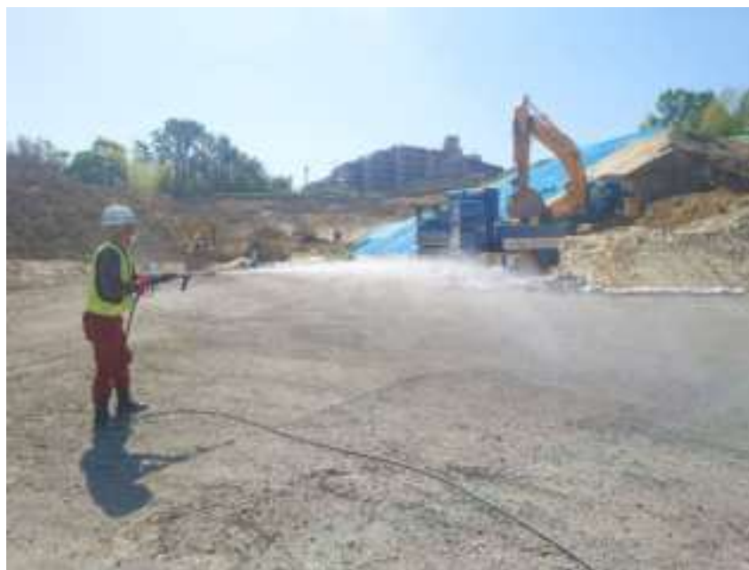
現場内の粉じん防止対策
