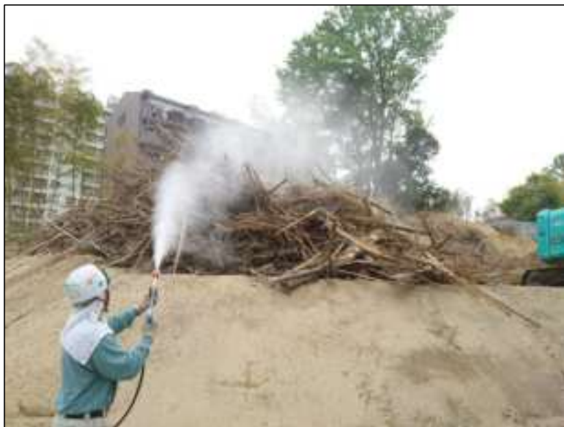
伐採材積込時の粉じん防止対策
