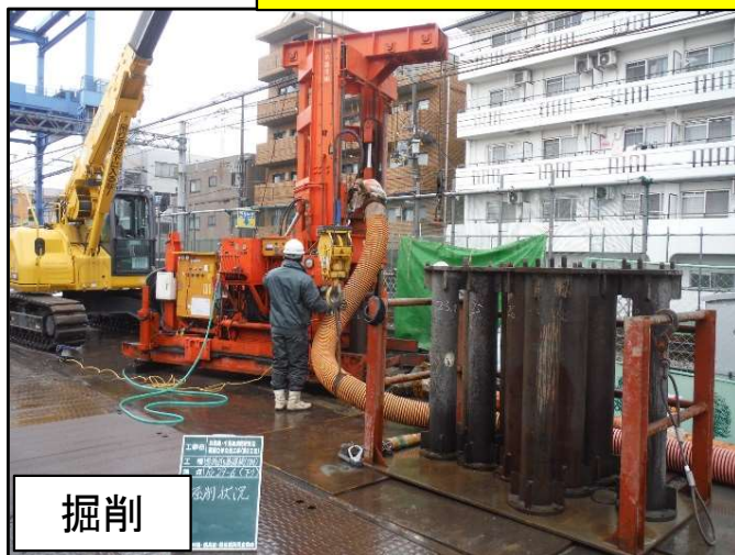
鉄道架線電柱移設に伴う基礎工事(イメージ)
