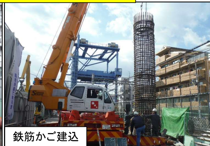
鉄道架線電柱移設に伴う基礎工事(イメージ)
