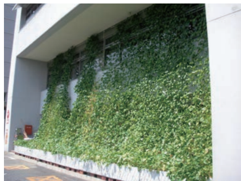
市役所本庁舎でのみどりのカーテン
