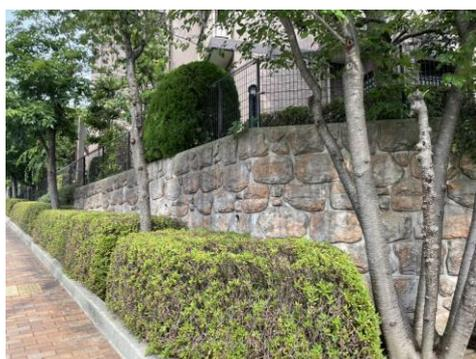
自然石風の化粧型枠を使用した擁壁と前面に植栽を配置した例
