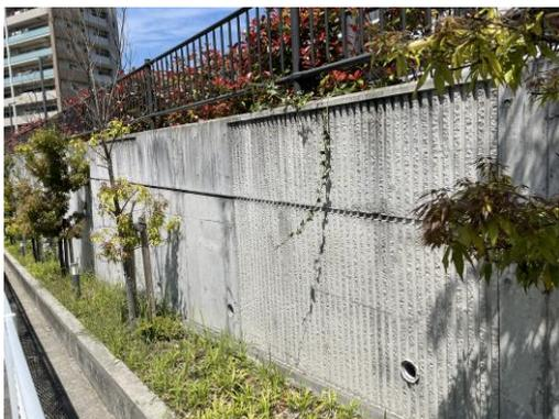
縦目地の化粧型枠を用い、圧迫感を低減した例
