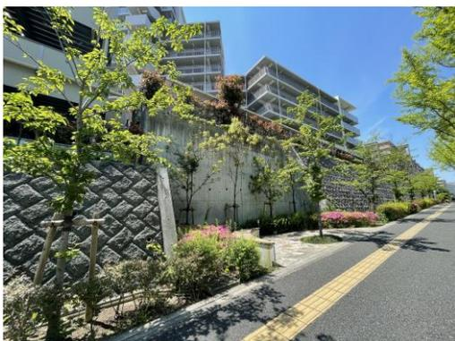
セットバックした石積み擁壁と前面に植栽を施した例
